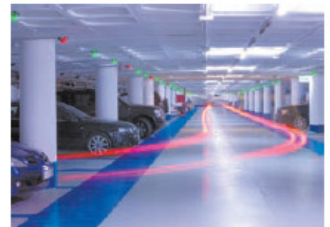
Sobre estas líneas se pueden ver algunas de las tecnologías que se emplean para la señalización de los parkings
